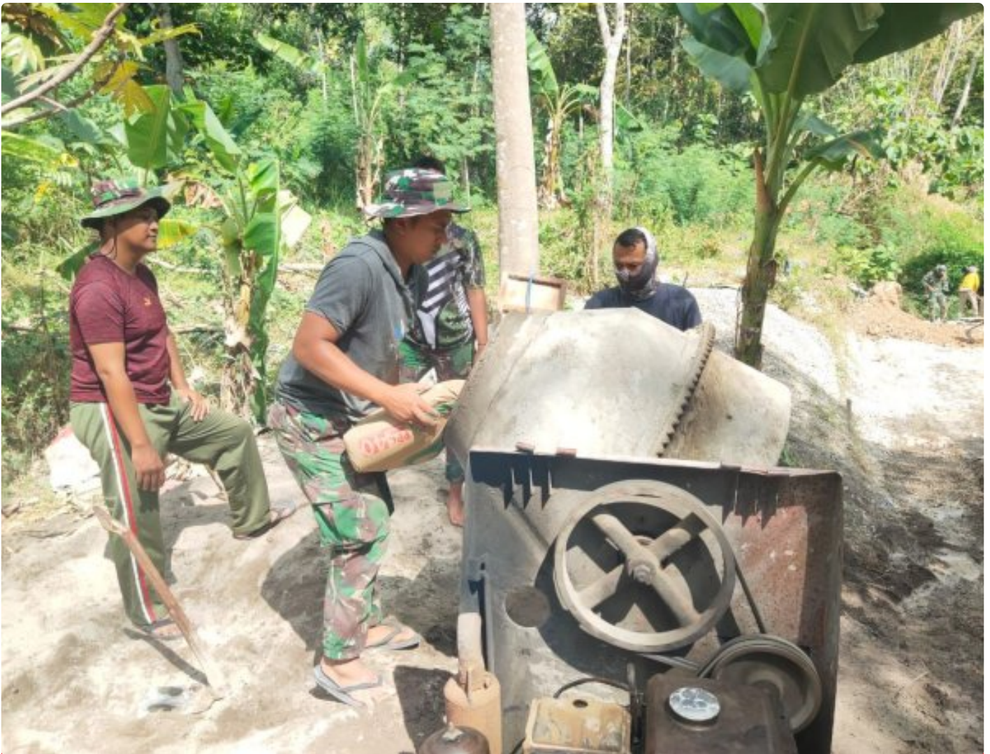
Foto: Mesin Molen, Senjata Utama Satgas Pembuatan Jalan Dalam Program TMMD ke-121 di Kodim Rembang.
